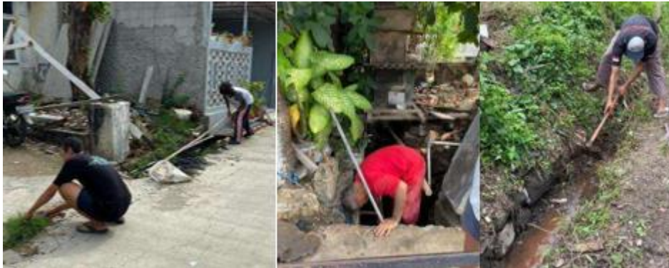
Gambar 3. Pembersihan selokan tipe tertutup dan terbuka (dokumentasi Jannah dan Aulia, 2023).
