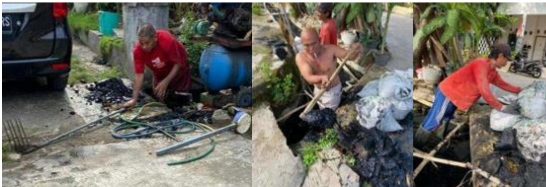
Gambar 4. Mengeruk sedimen (kiri dan tengah), serta memasukkan sedimen ke dalam karung (kanan) (dokumentasi Jannah dan Aulia, 2023).
